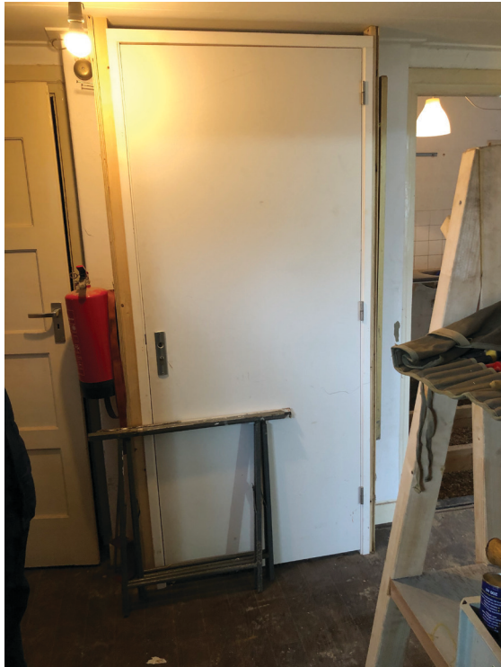
Tijdelijke stofdichte tussendeur
