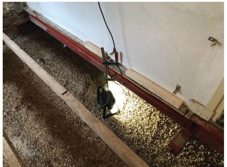
Stalen draagbalk onder keukenmuur
