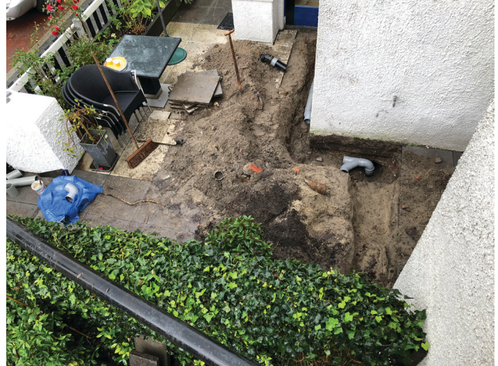
Rioolwerkzaamheden Papaverhof 3 en 1
