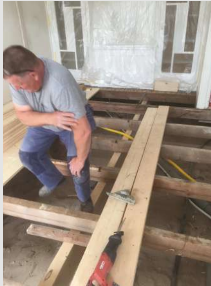
Vervangen van de vloerbalken
